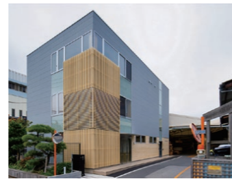
自社の製品を壁面やデッキに配した本社屋
