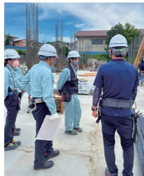
施工管理業務の様子
